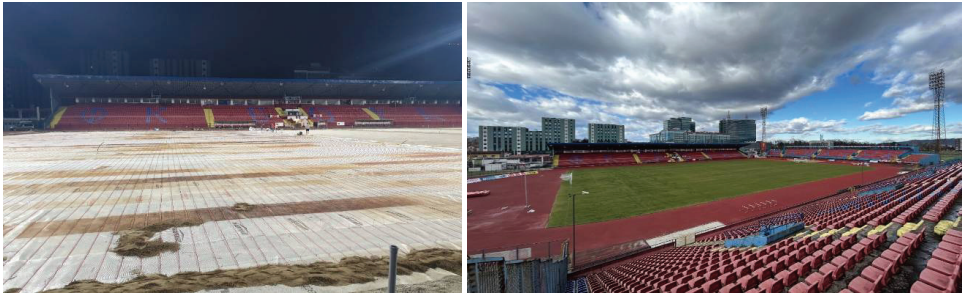
Слика 7: Постављање грејних инсталација и изглед реновираног Градског стадиона
